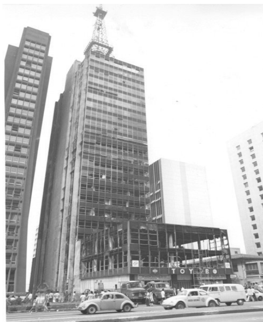
Figura 14 - Incêndio no Edifício Grande Avenida
