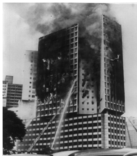
Figura 22 - Propagação por condução
