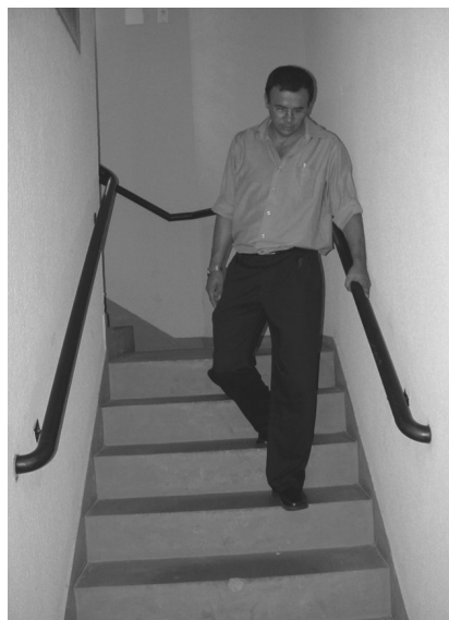
Figura 46 - Escada com largura apropriada para saída das pessoas
