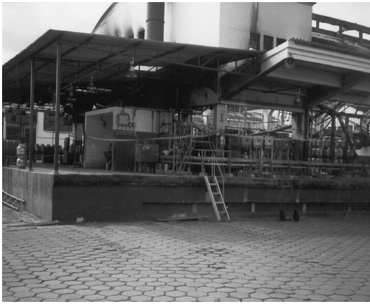
Figura 7 - Isolamento do local sinistrado
