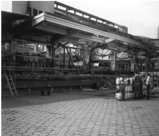
Figura 8 - Perícia de incêndio
