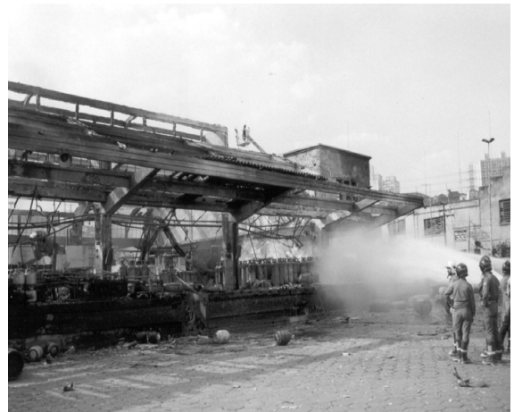
Figura 5 - Incêndio em engarrafadora de GLP
