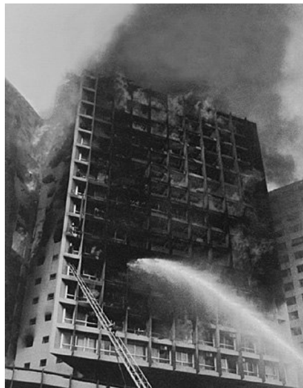
Figura 11 - Incêndio no Edifício Andraus
