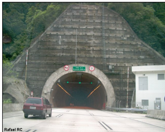
Figura 2 - Sinalização na entrada do túnel
