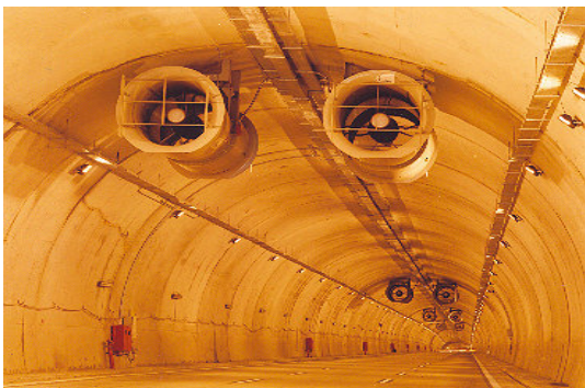
Figura 1 - Sistema de ventilação longitudinal
