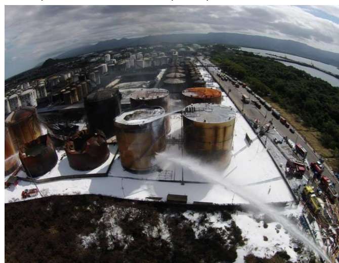
Figura 59: Incêndio em parque de tanques
