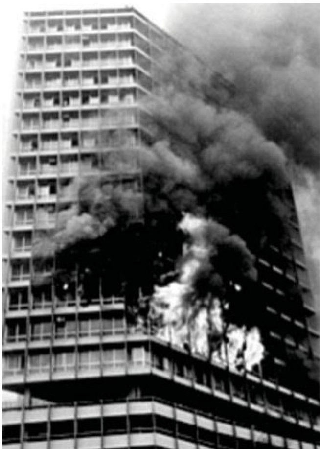
Figura 4: Incêndio no Edifício Joelma
