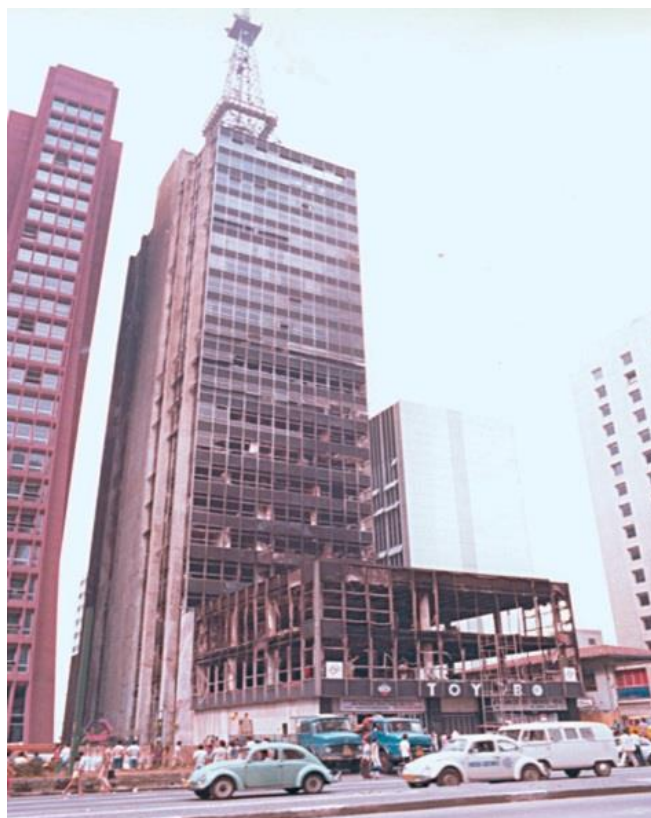
Figura 5: Incêndio no Edifício Grande Avenida
