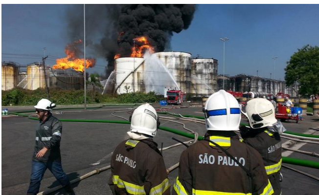
Figura 8: Incêndio em parque de tanques
