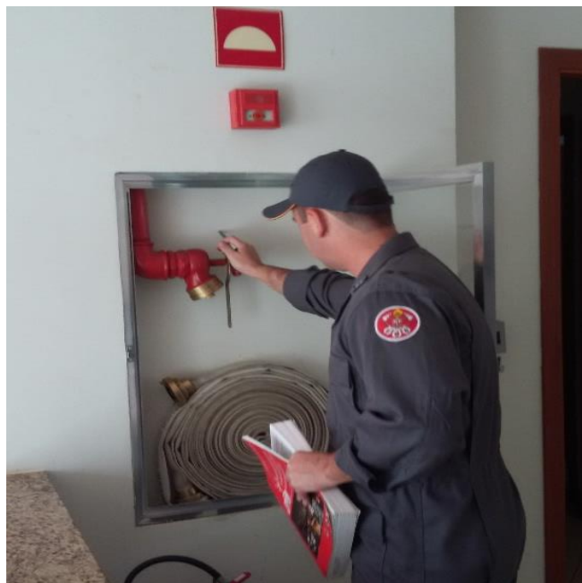
Figura 1: Vistoria em edificação para verificação das medidas de segurança contra incêndio e pânico.
