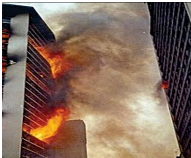
Figura 20: Propagação por convecção, onde gases quentes fazem com que ocorram focos de incêndio em outros andares.
