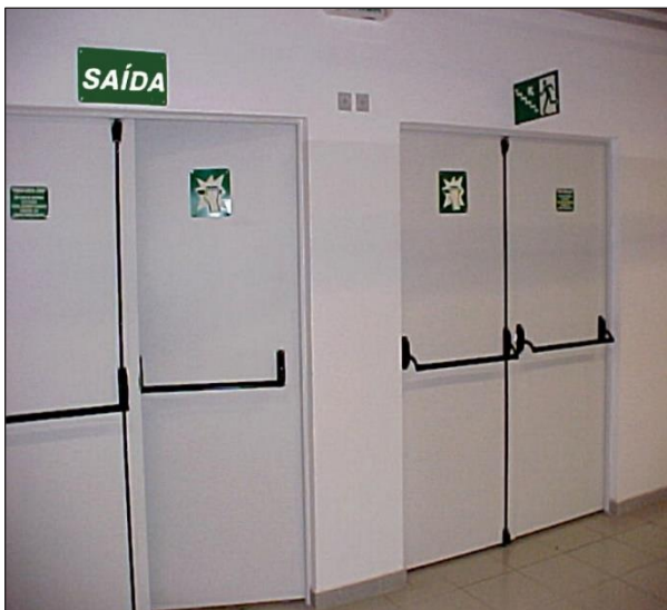
Figura 43: Porta com barra antipânico.
