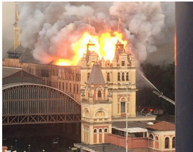
Figura 11: Incêndio no Museu da Língua Portuguesa
