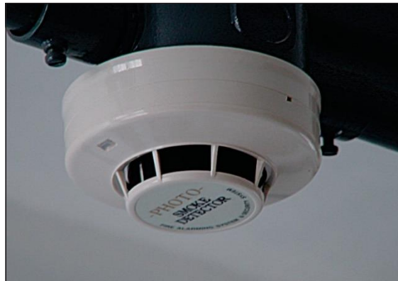
Figura 47: Detector de incêndio.
